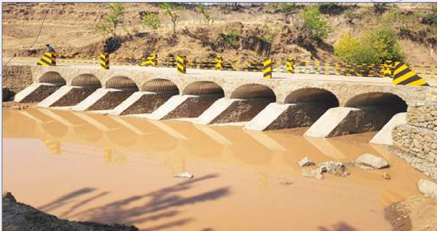
Mini Bridge at Mofoka – Morumotšo Gravel Road
